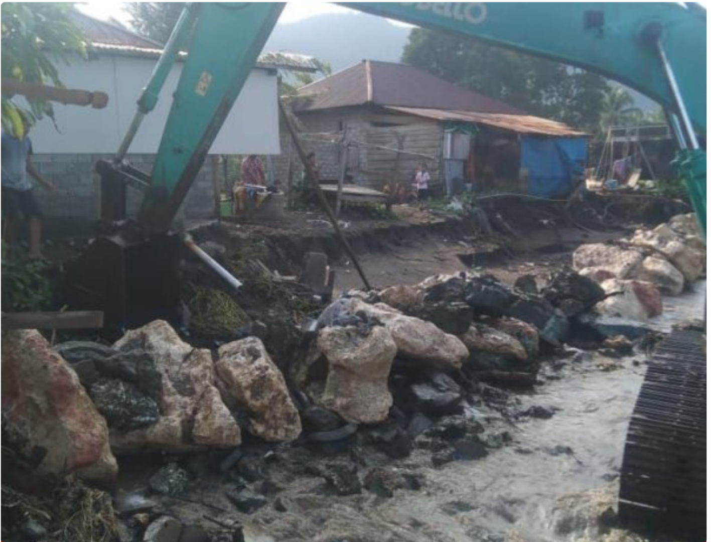
Proyek pemecah ombak di desa kolono
