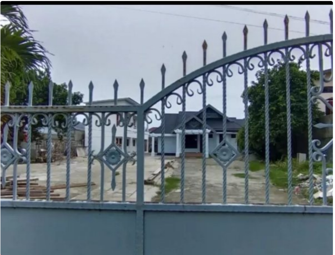
Mess Pemda Morowali di jln Garuda Palu
